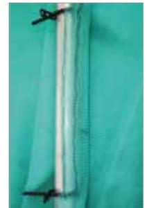
Bild 87: Befestigung einer Plane am Ständer
