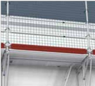
Bild 75: Schutzwand auf zweibohligten Konsolen
