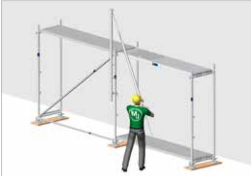
Bild 89: Einhängen des MSG-Geländerholms am ersten MSG-Pfosten
