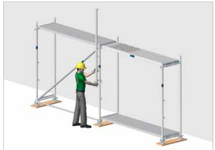
Bild 88: Montage des ersten MSG-Pfostens
