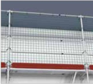
Bild 73: Schutzwand auf Vertikalrahmen
