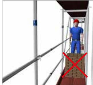
Bei Materiallagerung ausreichend breiten Durchgang auf dem Belag freilassen!
