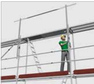
Bild 39: Montage des MSG im Aufstiegsfeld
