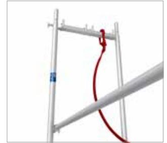
Bild 96: Anschlag am oberen Querriegel des Vertikalrahmens
