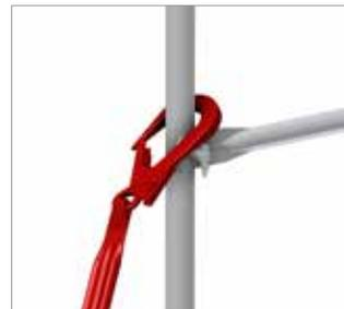
Bild 97: Anschluss am Ständer oberhalb des oberen Geländerholms
