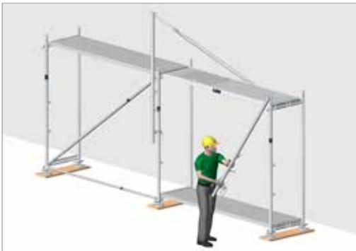
Bild 90: Einhängen des MSG-Geländerholms am zweiten MSG-Pfosten
