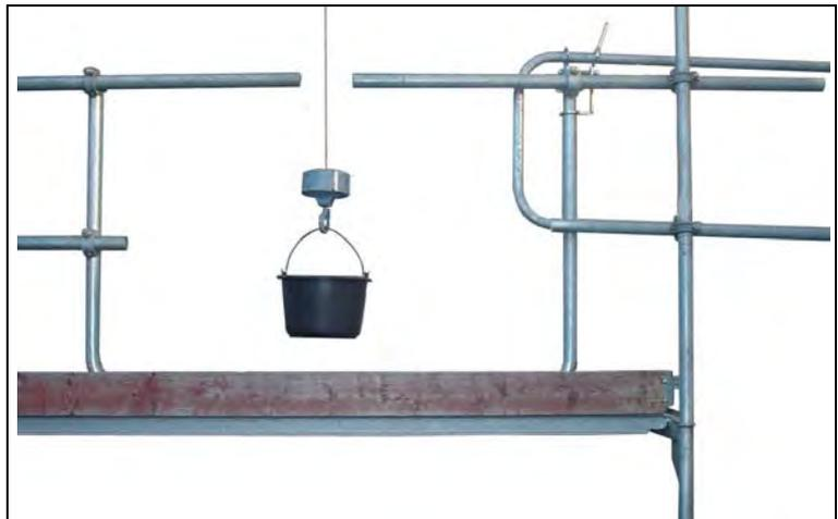
Fig. 14 Sicherung der Be- und Entladestelle
