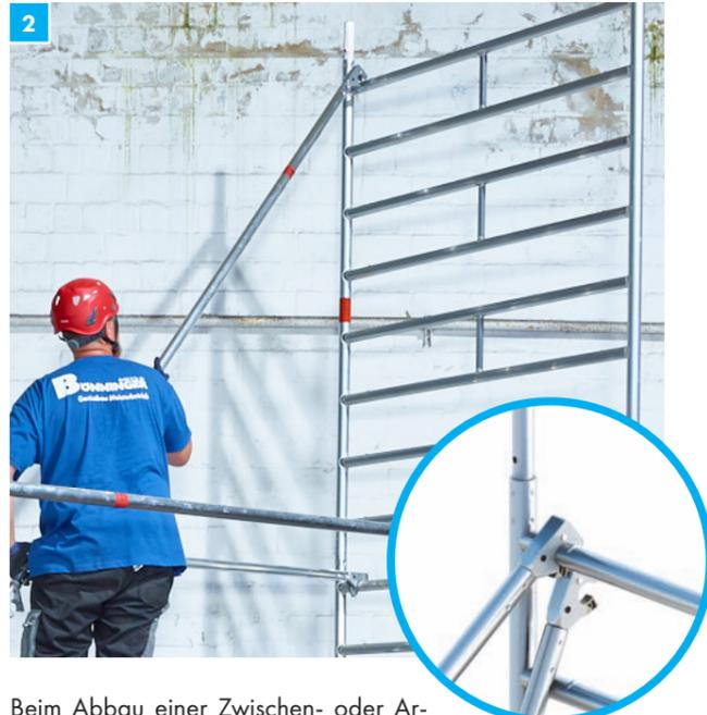
Beim Abbau einer Zwischen- oder Arbeitsbühne werden die obersten Rückenlehnen erst von der darunterliegenden Ebene aus demontiert. Dies geschieht mithilfe einer auf Kniehöhe eingebauten Rückenlehne.
