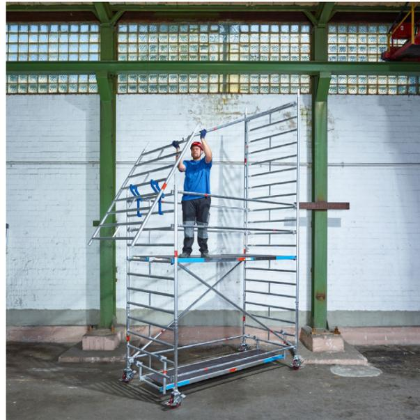
**[1]** 2 m-Standleiter 15 aufstecken und durch Federstecker 11 sichern. Anbringen der Uni Montagehaken 24 und Positionierung einer weiteren Standleiter 15 zur Montage der Rückenlehnen 12.
