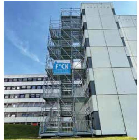
Gerüstbau Bönninger stattet Gebäude, die die Brandschutzanforderungen nicht vollständig erfüllen, mit Fluchttreppentürmen aus
