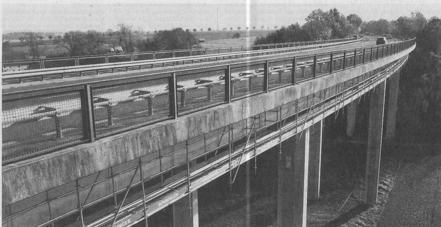
An der Talbrücke Haxtergrund musste ein Laufsteg in 26 m Höhe hängend montiert werden.
