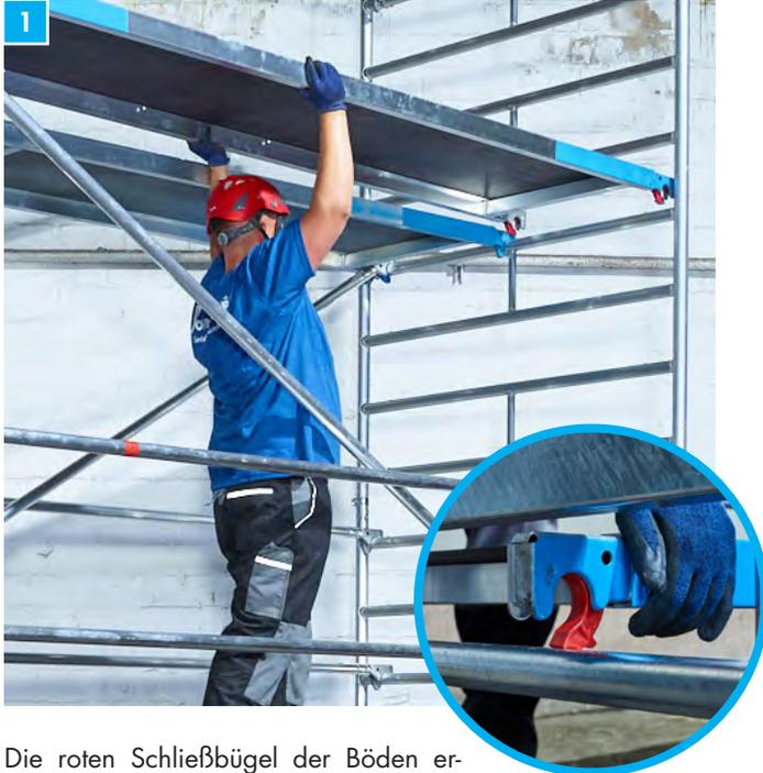
Die roten Schließbügel der Böden ermöglichen den mühelosen Ein- und Ausbau durch eine Person; sie sind zuerst zu lösen und der Belag mit den geöffneten Bügeln auf die Sprosse aufzulegen, dann erst werden die gegenüberliegenden Bügel gelöst und der Belag ausgehoben.
