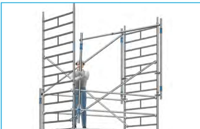
Versetzen des MSG nach oben
