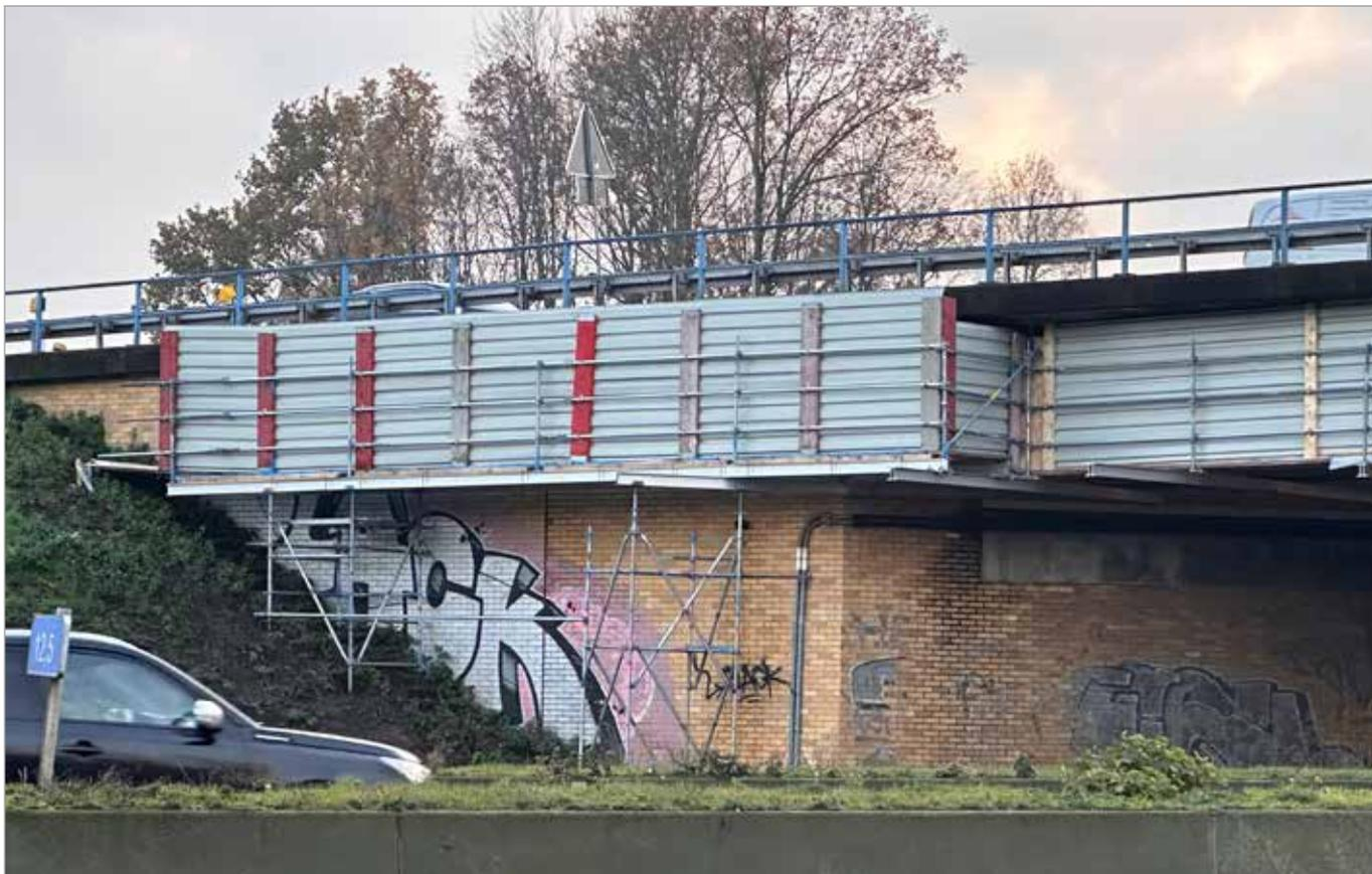
Abb. 5 (oben) und 5a (links unten): Zugang zum Hängegerüst vom Widerlager aus, Quelle: Ingenieure Tomshöfer & Partner, Bochum
